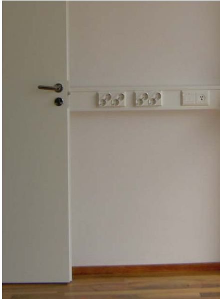
Kuva 4. Normaalia ylemmäs sijoitetut pistorasiat
